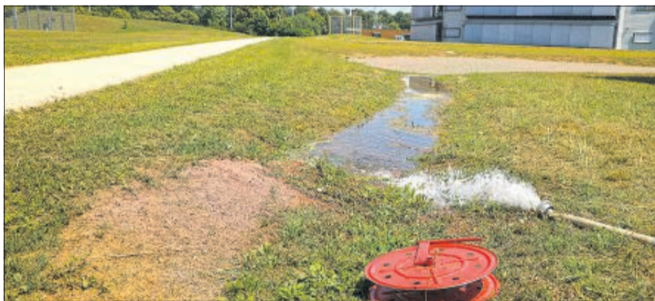
Obacht: Hier wird kein Teich mit Wasser gefüllt, wie Anwohner vermuten, sondern ein Versickerungsbecken für das Regenwasser getestet. Foto: astavi
